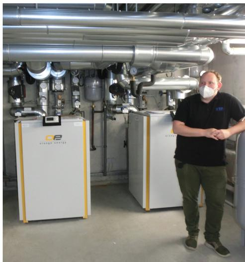
**Klimafreundlich: Wärmepumpen zum Heizen und Kühlen, betrieben mit Solarstrom vom eigenen Dach**
